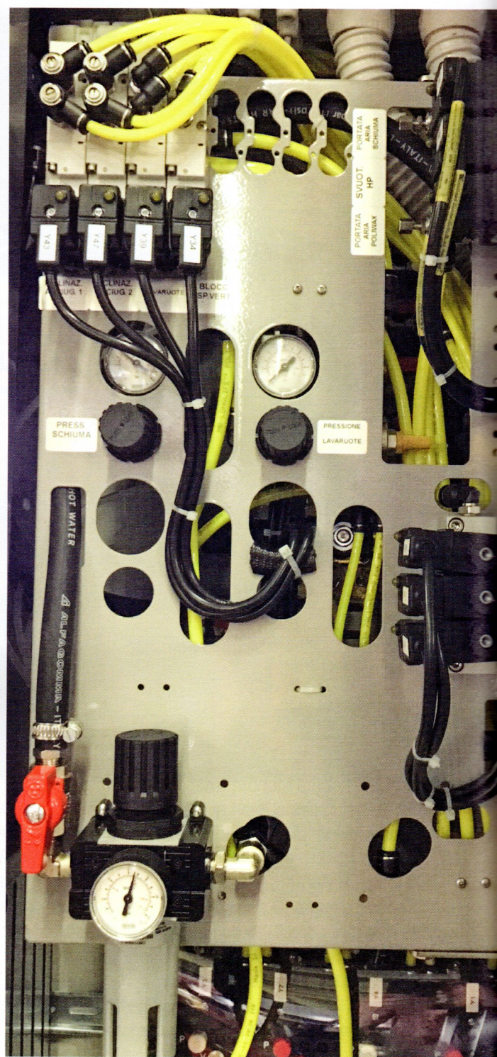
Le elettrovalvole e gli FRL Aignep provvedono all'apertura e alla chiusura dei circuiti nella gestione dell'acqua dell'impianto.
